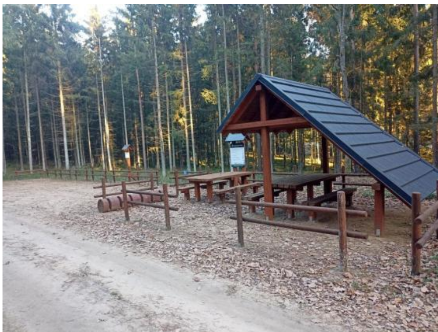
Ryc. Miejsce postoju pojazdów
